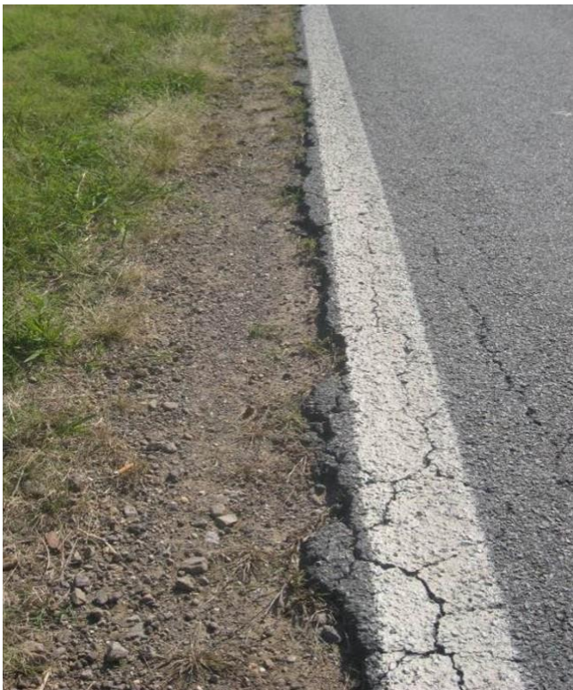
Edge Cracking
