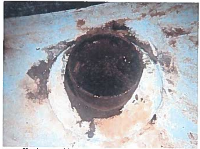
56 Unobstructed Influent./Effluent Pipe
